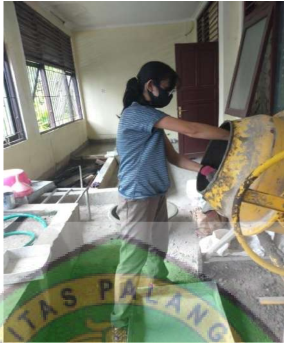
Gambar 3.9 Pengadukan Menggunakan Mesin Molen
